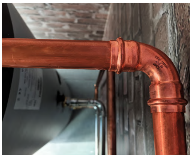
Figura 16 - aesPRES UNIKO - Impianto di riscaldamento
