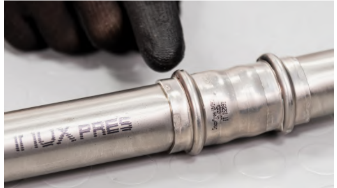
Figura 26 - Controllo della pressatura
